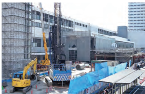
工事が進むエキキタ周辺
